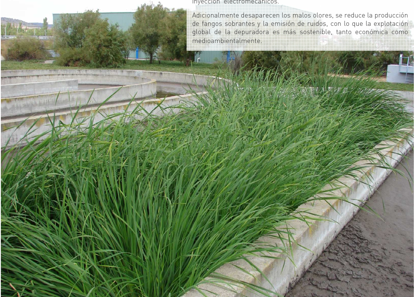
Edar de tipo Carrusel de fangos activos combinada con sistema Hidrolution FMF, Villacañas (Toledo).
